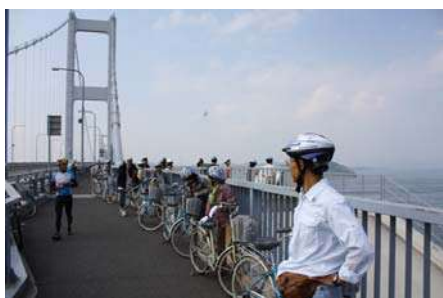
「来島海峡大橋」
